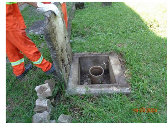
Foi realizado mapeamento e estudo próximo ao prédio 05 (PD05), onde detectou-se muitas caixas de passagem, pelo fato de ter existido no passado um sistema de tratamento de esgoto industrial neste local.
